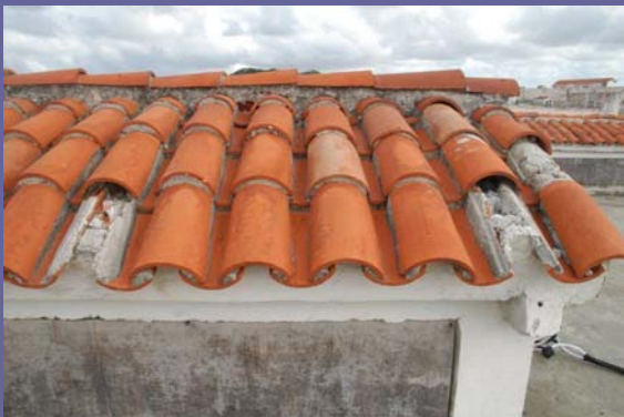
Vermörtelte klassische Mönch-Nonnen-Dachziegeldeckung auf den Gebäuden innerhalb der Festung
