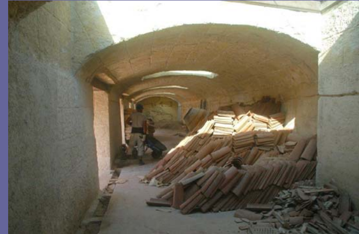
Lagerung von Dachziegeln in trockenen Kasematten
