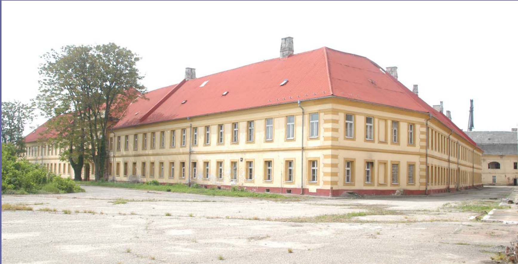
Sanierte Kasernenanlage in der Neuen Festung
